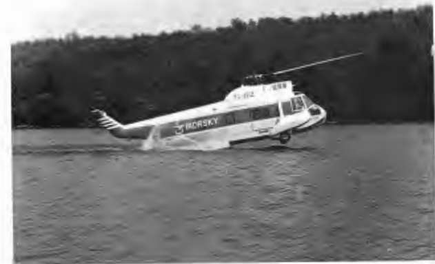
Der erste Amphibien-Hubschrauber. SIKORSKY S-62 kann auf jedem Boden, Wasser, Eis, Sumpf und Schlamm landen.
